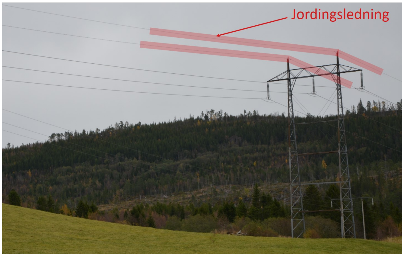
Figur 20. Illustrasjon av objekttype Jordingsledning
