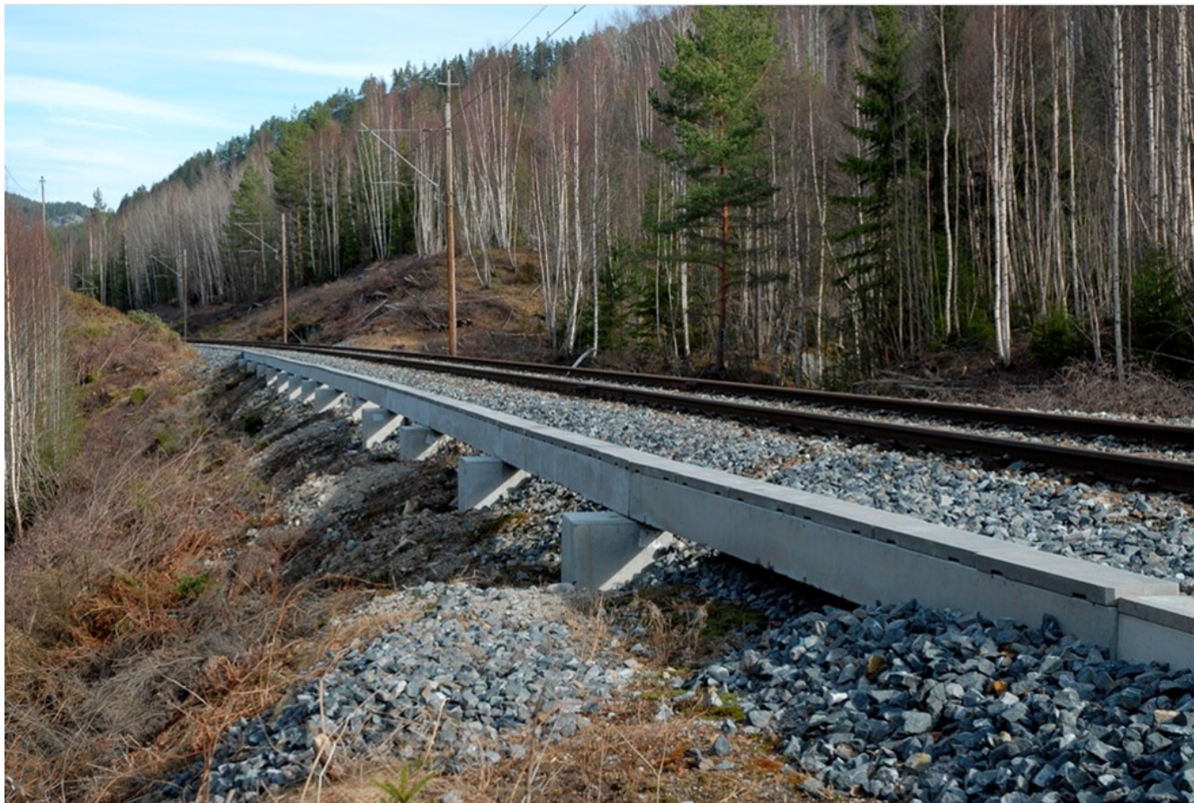
Figur 21. Illustrasjon av objekttype Kabelkanal
