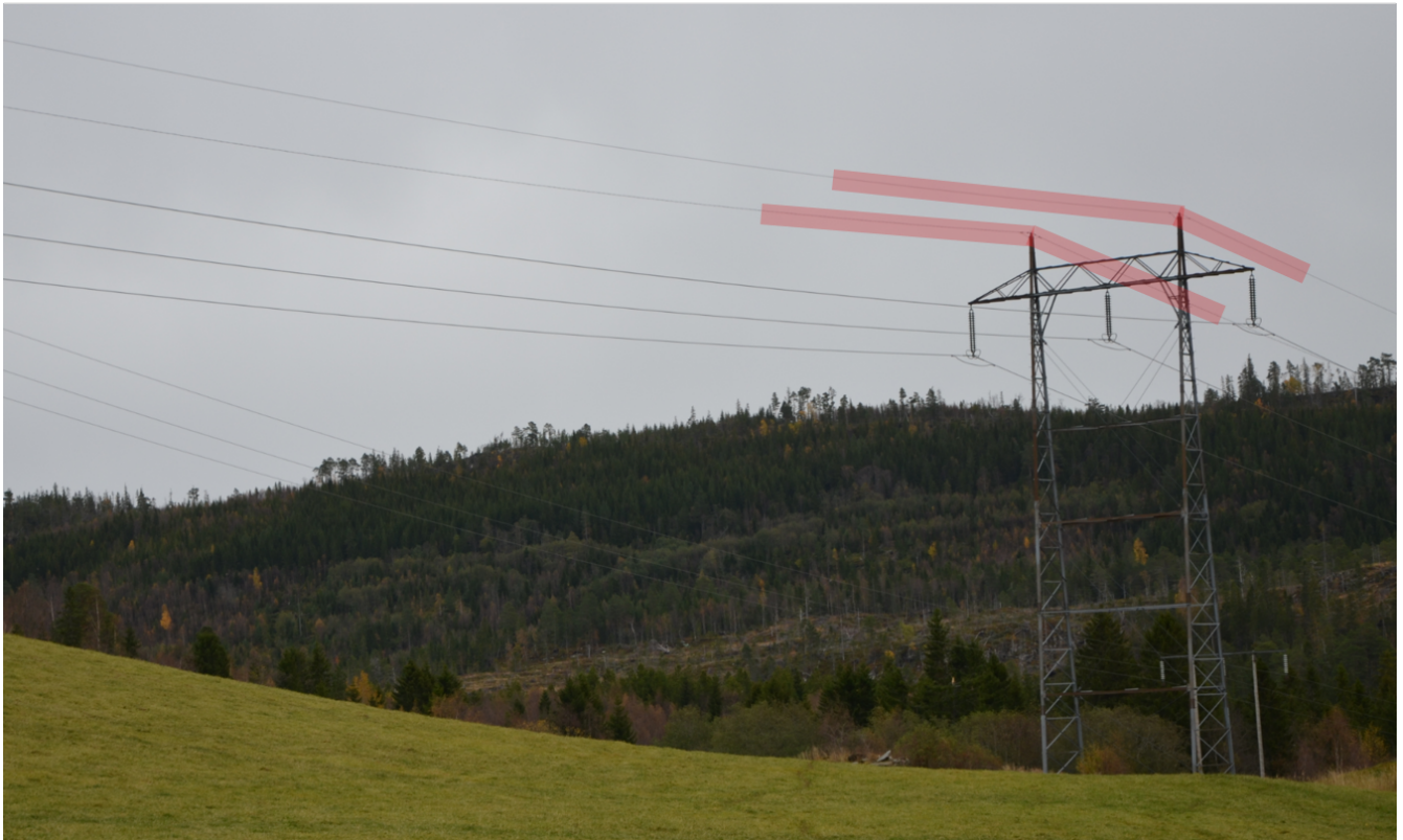
Figur 7. Eksempel på jordingsledning (toppline).
