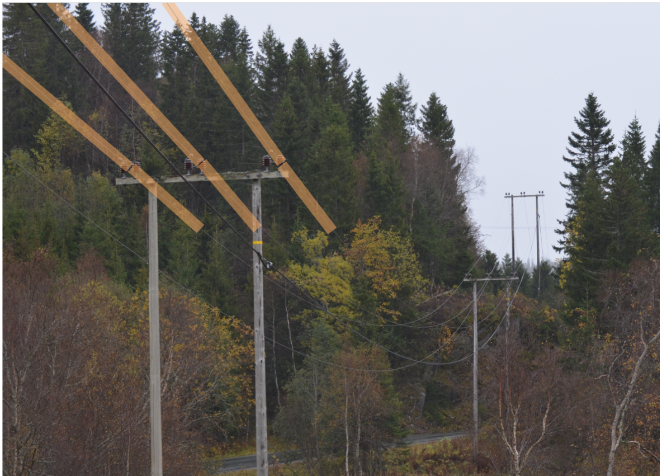
Figur 9. Eksempel på faser i høyspent (distribusjonsnett)
