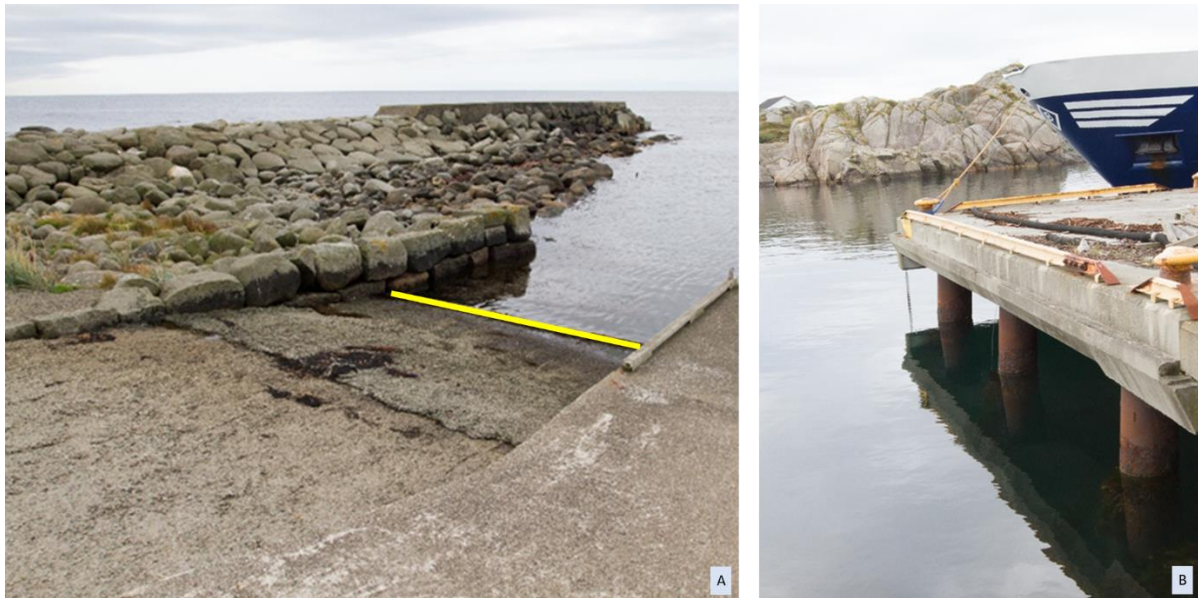
Bilde 12. A. Rampe. Registreres som Kaifront – kaifronttype «rampe». Mål inn ved vannkant. B. Søylekai. (Foto: Kartverket, 2021)
