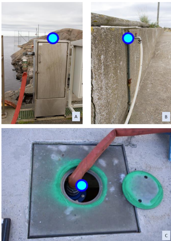
Bilde 16. VAuttak. A. Innmålingspunkt på toppen av skapet. B. På mindre VAuttak settes innmålingspunkt ved vannkranen. C. VAuttak i Kristiansand havn. Her registreres punktet på midten av VA-uttaket. Høydereferanse: Topp. Norkart, 2020.
