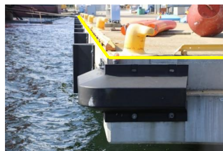
Bilde 10: Kaifront er lagt inn med gul linje. Kailengden måles opp på den delen av kaifronten som egner seg for anløp av skip. Høydereferanse: Topp. Norkart, 2020.
