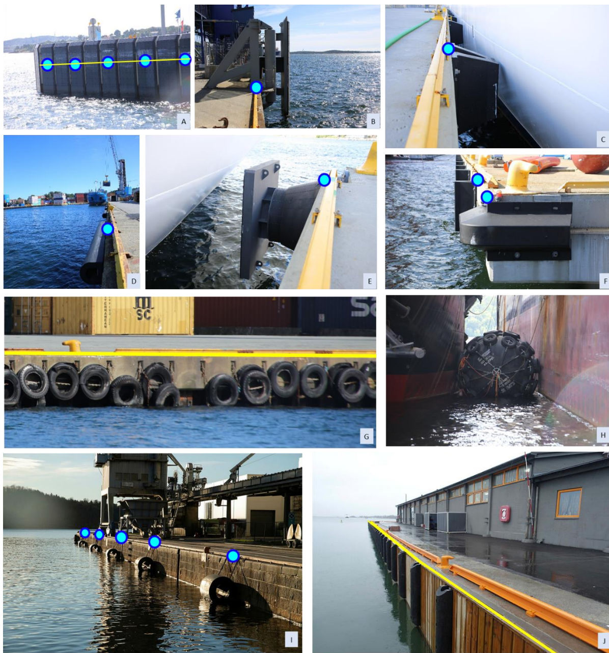
Bilde 14: Eksempler på noen ulike fendertyper. Bildene er fra Kristiansand havn og Oslo havn (Foto: Norkart og Oslo havn KF).
