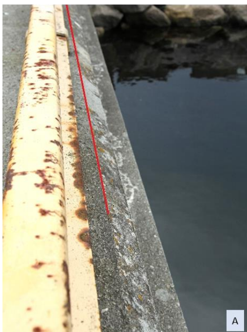
Bilde 11. A. Kaien/Kaifronten er ofte i praksis ikke en skarp 90 graders knekk, men kan ha en skråkant eller annen form for avrundning. Kaifronten måles inn på toppen, langs den ytterste linjen, før konstruksjonen skrår eller avrundes. Se linje inntegnet med rødt i bildet. Foto: Kartverket, 2021. B. Flere kaifronten (nr.1 til 3) kan dele ett kaiområde (skravert område).
