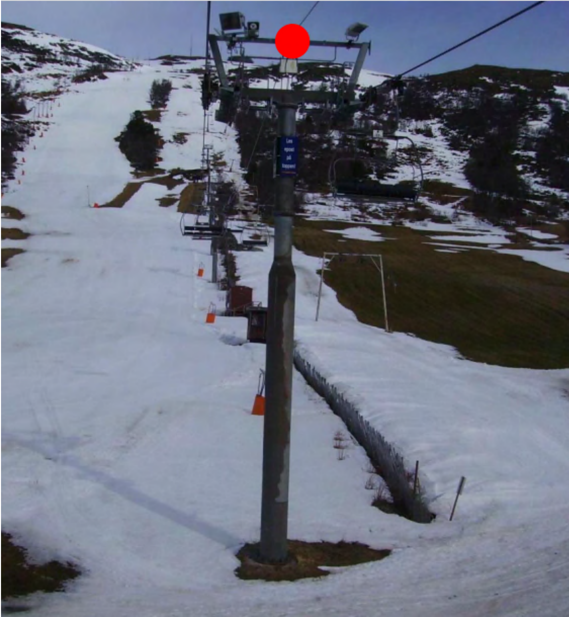
Figur 55. Eksempel på registrering av mast for stolheis
