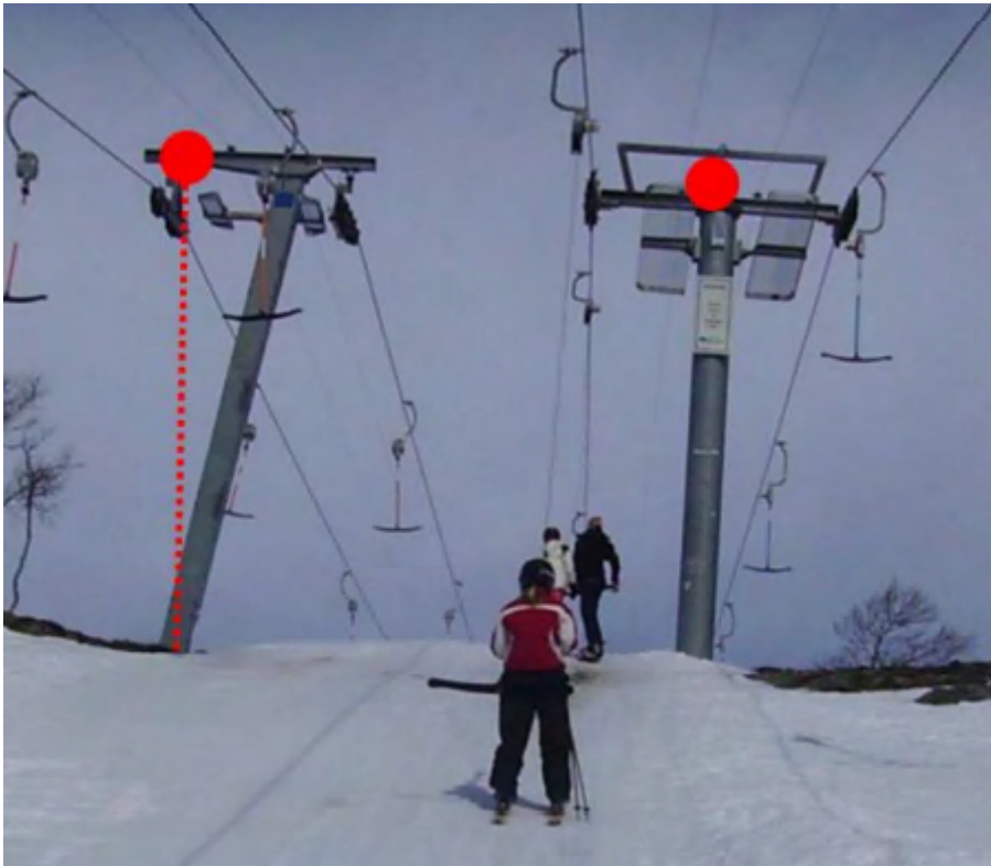
Figur 54. Eksempel på registrering av taubanemast i skitrekk
