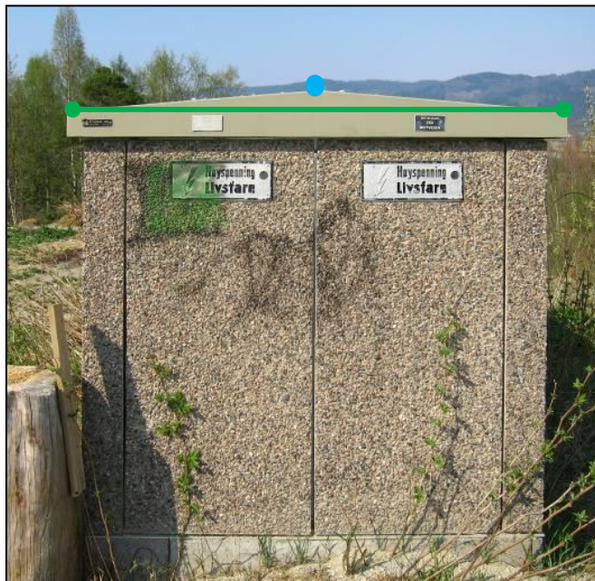
Figur 16: Eksempel på registrering av EL_Nettstasjon (Minikiosk) som representasjonspunkt (blå prikk). Figuren viser også Nettverkstasjonsomriss (EL_Nettstasjon) (grønn strek) som også skal registreres.
