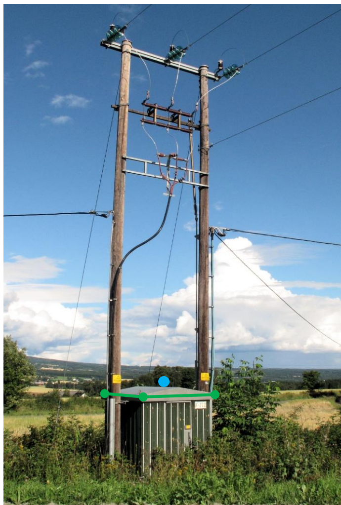
Figur 18 Eksempel på registrering av EL_Nettstasjon (mastefotstasjon) som omriss (blå prikk). Figuren viser også symbol for Nettverkstasjonomriss (EL_netstasjon) (grønn strek).
