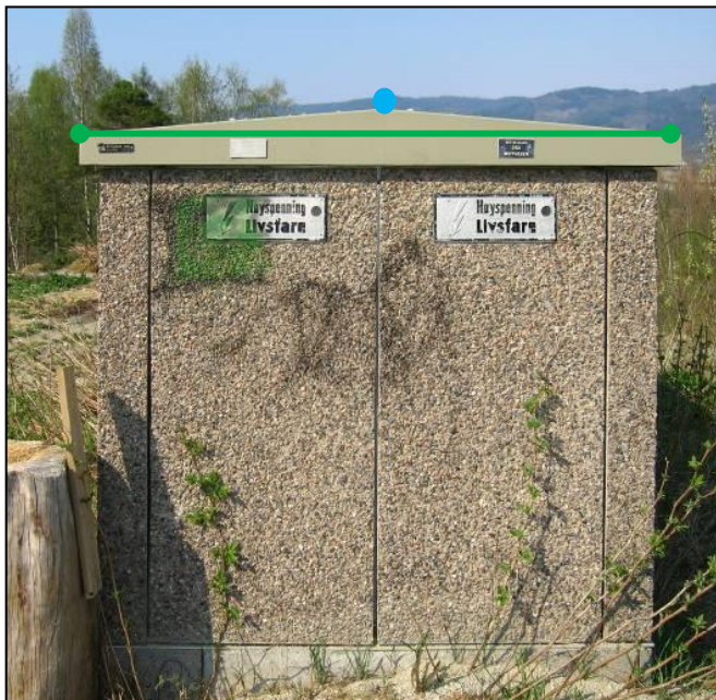
Figur 21: Eksempel på registrering av nettverkstasjon (EL_Nettstasjon) som omriss (grønn strek). Figuren viser også symbol for EL_Nettstasjon (minikiosk) (blå prikk), Dette punktet skal som minimum alltid være registrert.
