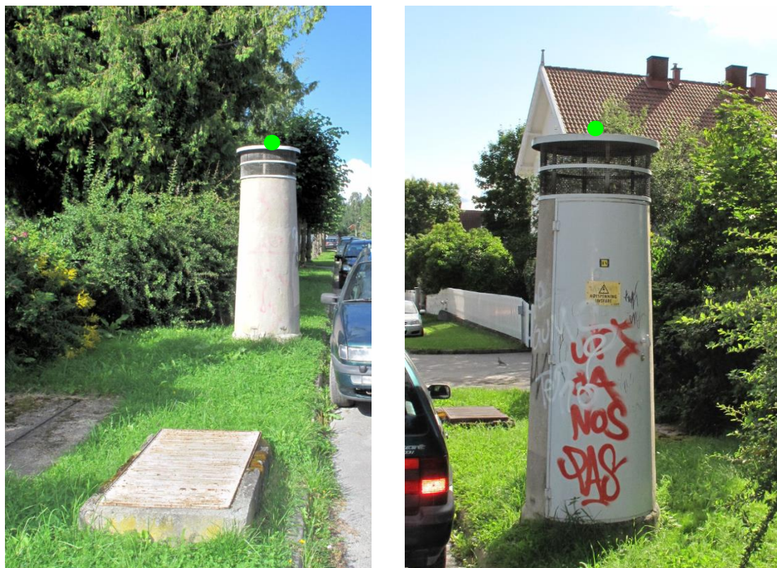
Figur 20: Eksempel på registrering av NettstasjonAdkomst (utlufting) (grønn prikk).
