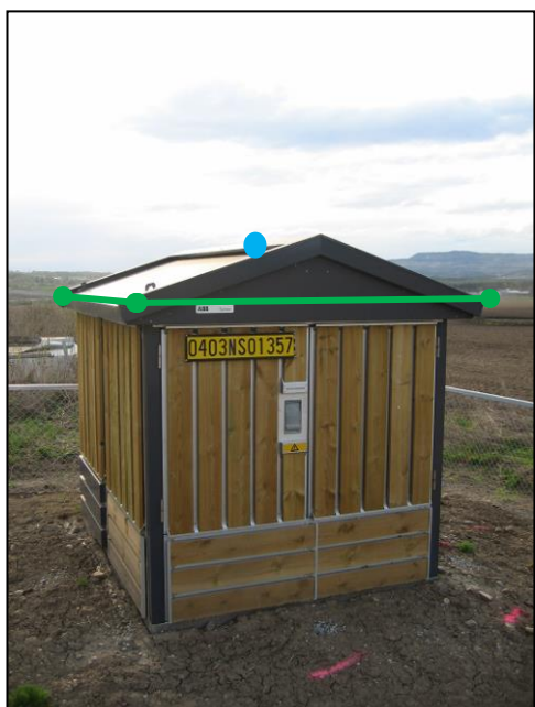
Figur 16: Eksempel på registrering av EL_Nettstasjon (Minikiosk) som representasjonspunkt (blå prikk). Figuren viser også Nettverkstasjonsomriss (EL_Nettstasjon) (grønn strek) som også skal registreres.
