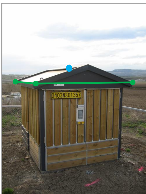
Figur 21: Eksempel på registrering av nettverkstasjon (EL_Nettstasjon) som omriss (grønn strek). Figuren viser også symbol for EL_Nettstasjon (minikiosk) (blå prikk), Dette punktet skal som minimum alltid være registrert.
