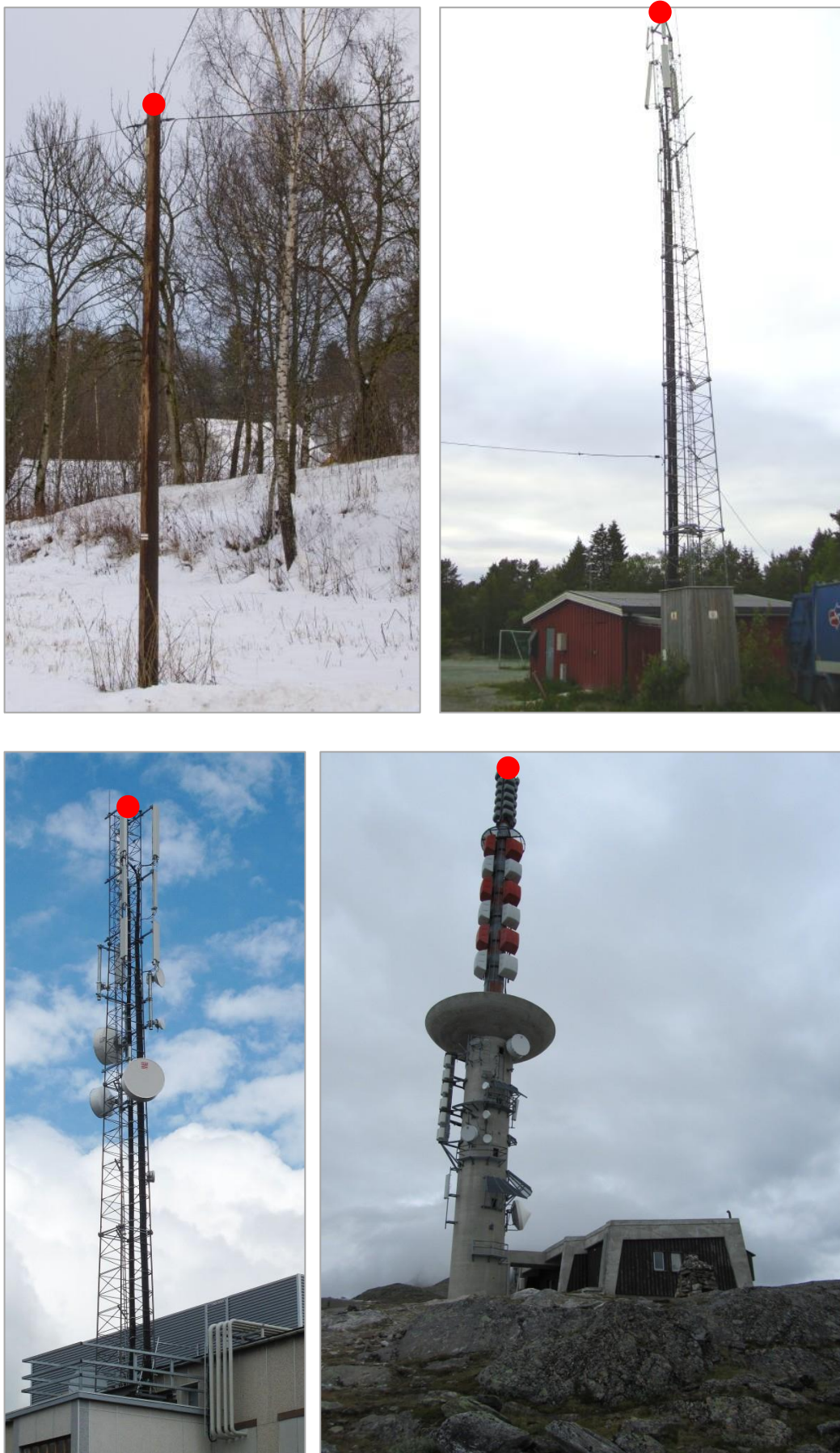
Figur 8: Eksempel på hvordan utvalgte master skal registreres. Representasjonspunktet for Mast er tegnet med rød prikk
