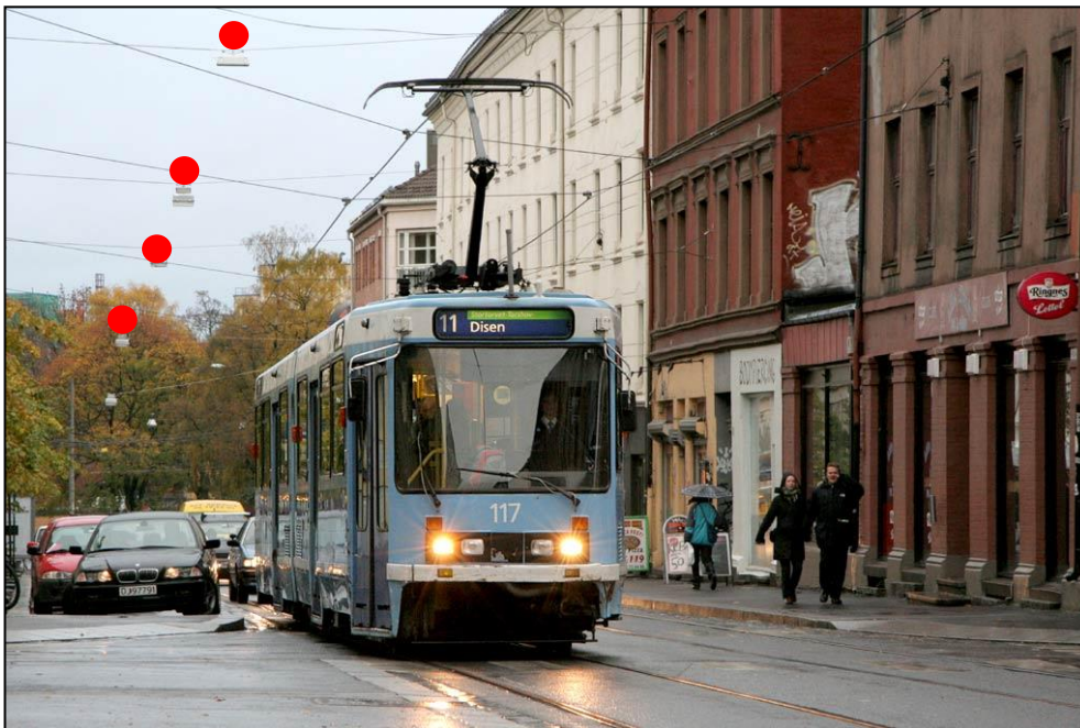
Figur 7: Eksempel på registreringspunkt for et utvalg EL_Belysningspunkt. Ved registrering av topp skal det tas hensyn til at mastene er skjeve slik at grunnrissreferansen tilsvarer senter av stolpen ved bakkenivå
