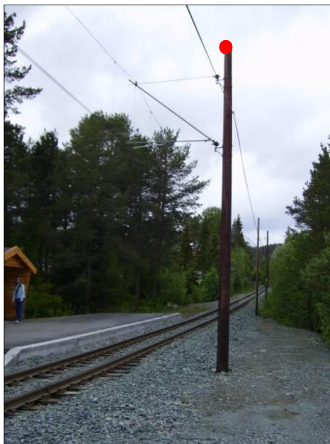
Figur 8: Eksempel på registrering av kontaktledningsmast ved bane
