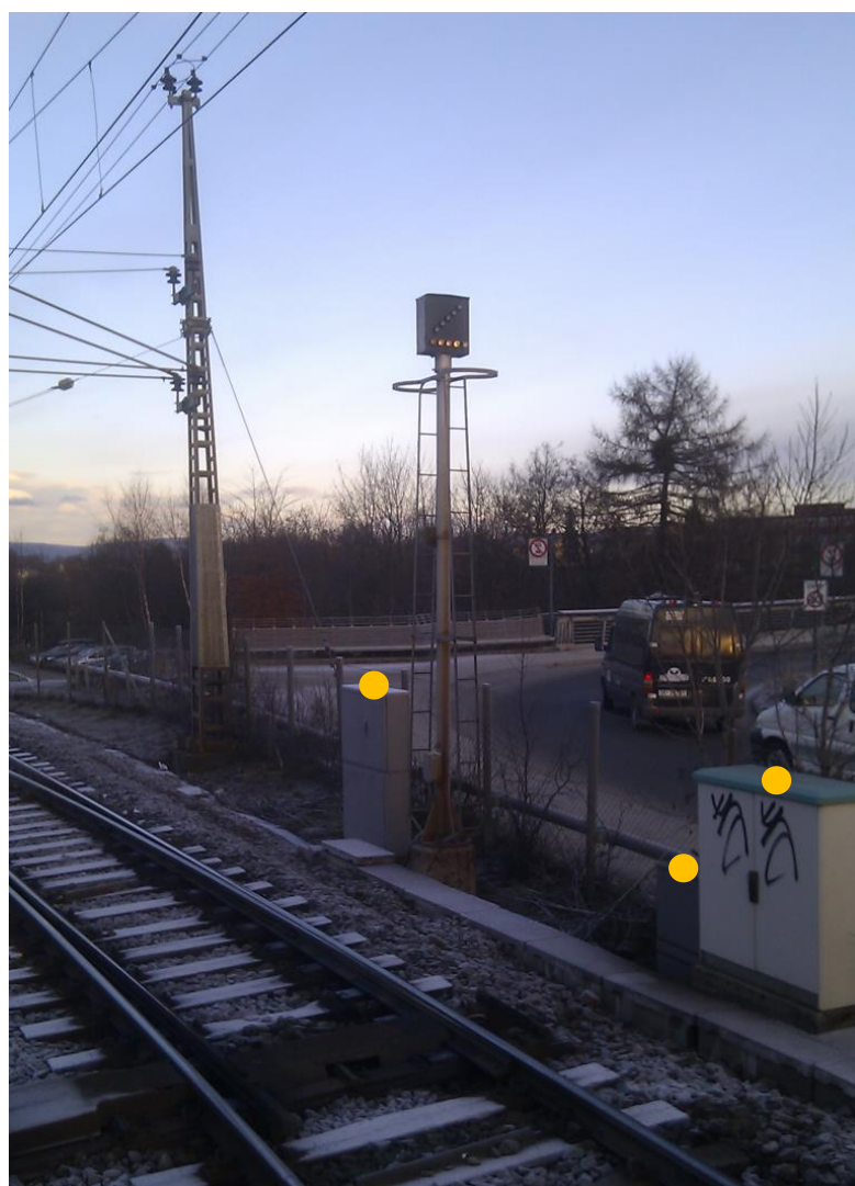
Figur 6: Eksempel på registrering av skap (gul prikk) ved kabelkanal ved bane.
