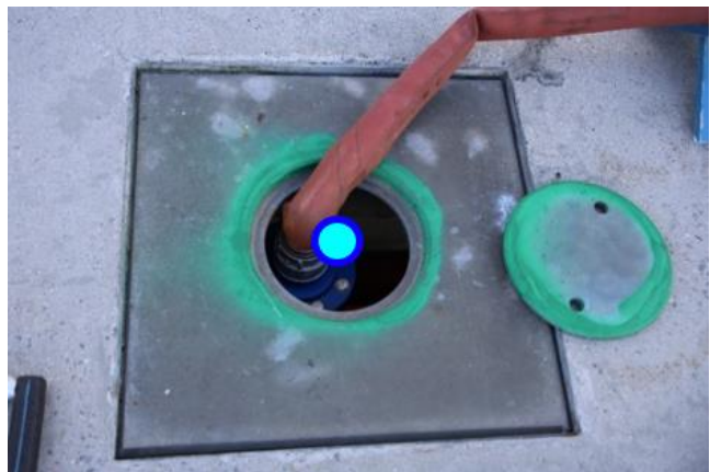
Bilde 16: Vanntilkobling i Kristiansand havn. Høydereferanse: Topp. Norkart, 2020.
