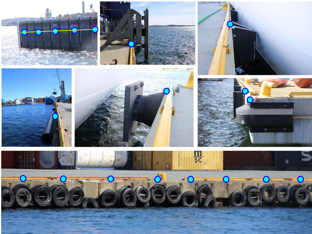
Bilde 10: Eksempler på noen ulike fendertyper i Kristiansand havn. Høydereferanse: Topp. Bruk toppunkt for festet til kaien. Gul linje i bildet oppe t.v. illustrerer hvor kaifronten går bak fenderne. Innmåling gjøres på baksiden av fenderne ved feste til kaien. Egenskapen fenderspesifikasjon brukes til å spesifisere målene til fenderen. Norkart, 2020.
