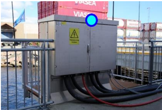
Bilde 15: Strømtilkoblingspunkt i Kristiansand havn. Registreres som enkelt punkt på objektets midtpunkt i toppen av objektet, tilsvarende som for fordelingskap i FKB. Høydereferanse: Topp. Norkart, 2020.
