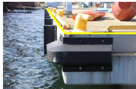
Bilde 4: Kaifront er lagt inn med gul linje. Kailengden måles opp på den delen av kaifronten som egner seg for anløp av skip. Høydereferanse: Topp. Norkart, 2020.
