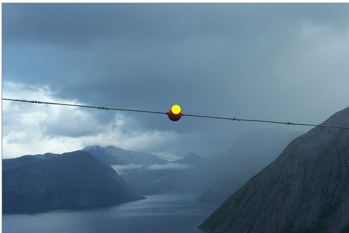
Figur 15: Eksempel på registrering av EL_Flymarkør (gul prikk)
