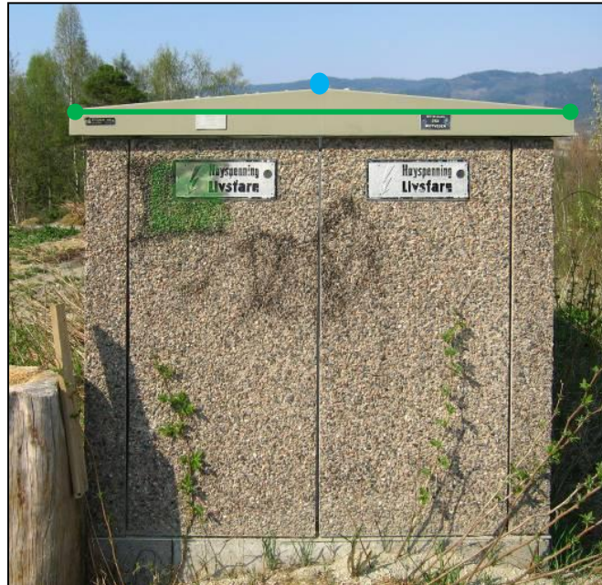
Figur 11: Eksempel på registrering av EL_Nettstasjon (Minikiosk) som representasjonspunkt (blå prikk). Figuren viser også Nettverkstasjonsomriss (EL_Nettstasjon) (grønn strek) som også skal registreres.
