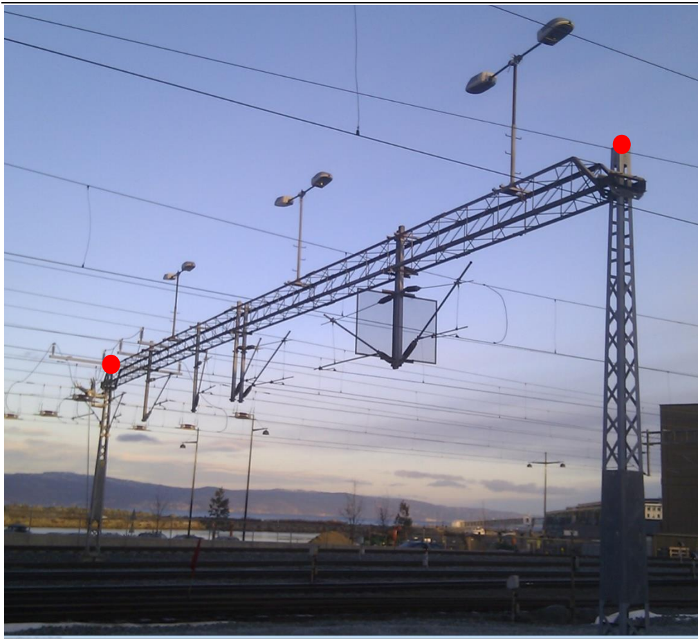
Figur 22: Eksempel på registrering av kontaktledningsmast med åk
