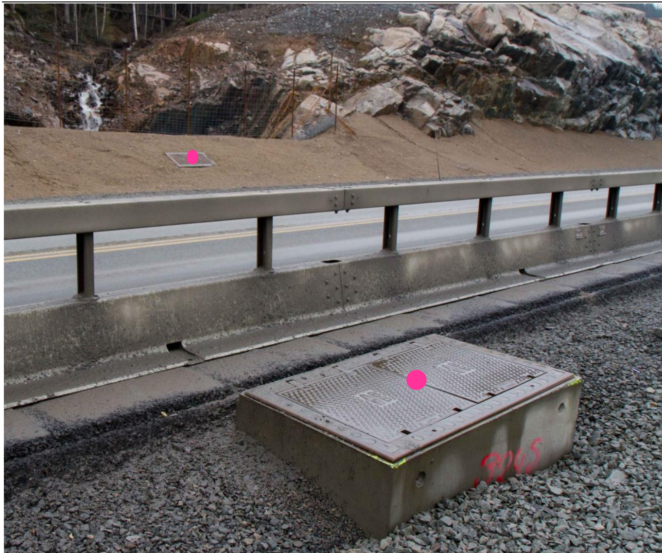
Figur 9: Eksempel på registrering av LednKum (Trekkekum) som representasjonspunkt (lilla prikk).
