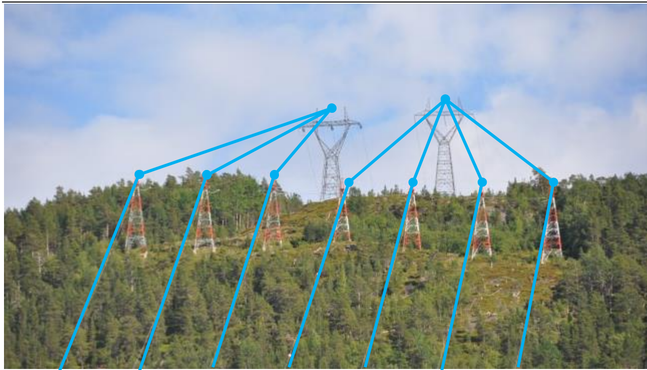
Figur 30: Eksempel på registrering av trase med forgreining.
