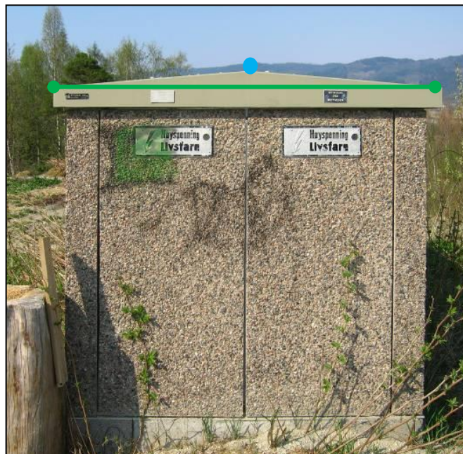
Figur 18: Eksempel på registrering av nettverkstasjon (EL_Nettstasjon) som omriss (grønn strek). Figuren viser også symbol for EL_Nettstasjon (minikiosk) (blå prikk), Dette punktet skal som minimum alltid være registrert.
