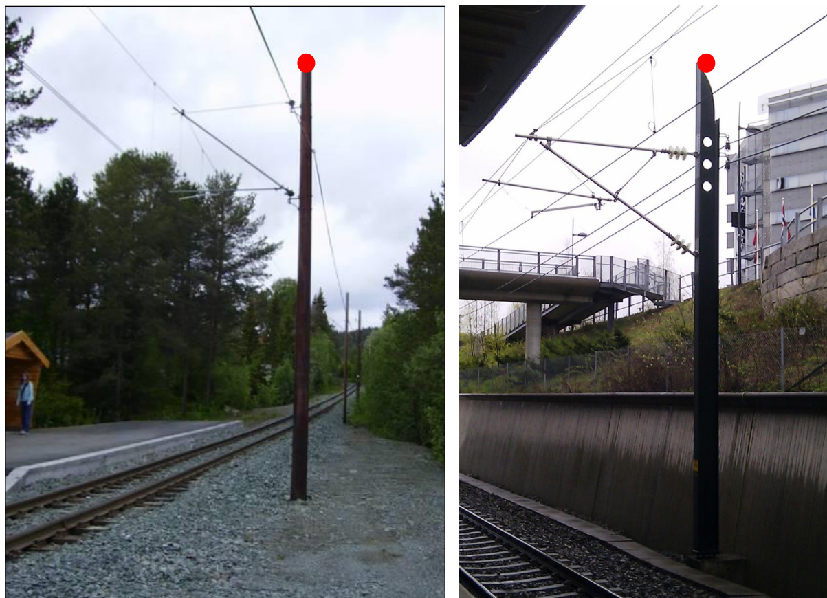
Figur 21: Eksempel på registrering av kontaktledningsmast ved bane
