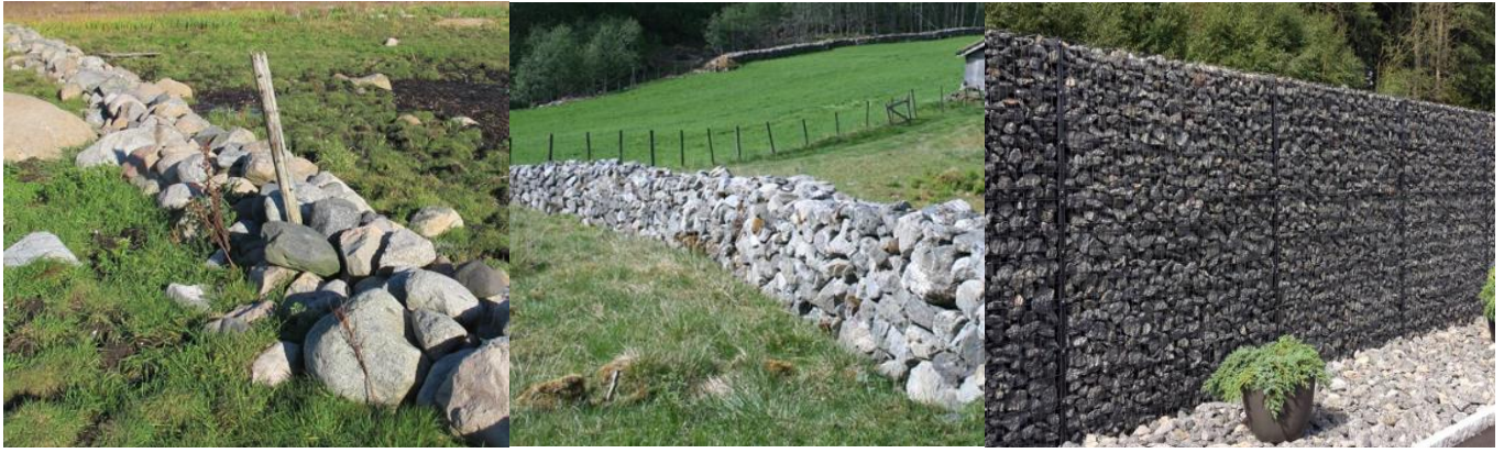
Figur 18: Bilder på ulike typer steingjerder. Nyere steingjerder bygget med netting skal registreres som steingjerde om de oppfyller minstehøyde. For eldre steingjerder kan det være vanskelig å bedømme høyde.
