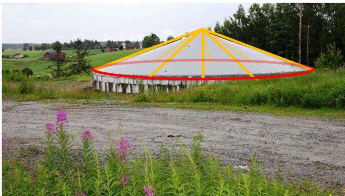
Figur 16: Eksempel på registrering av lukket gjødselkum (med tak) som MurFrittstående (rødt) og BeskrivendeHjelpelinjeAnlegg (gult).
