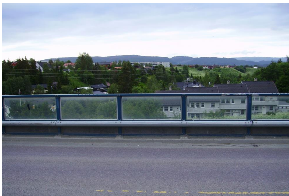
Figur 20: Innglassede skjermer skal registreres som støyskjerm.
