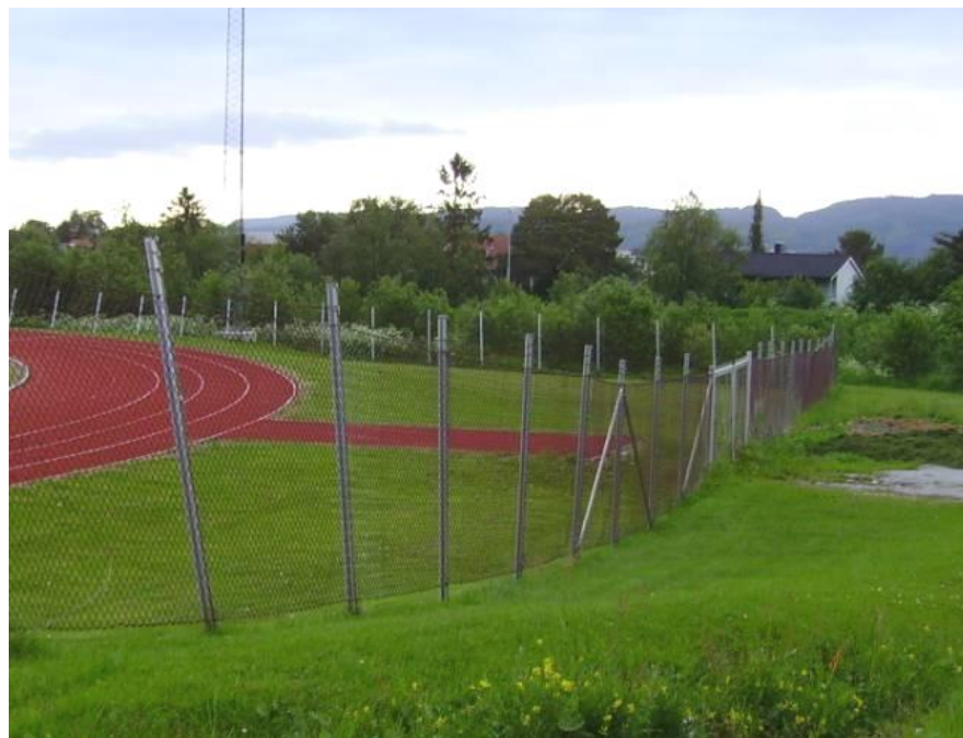
Figur 11: Fortrinnsvis skal topp gjerde registreres, men der dette er vanskelig registreres gjerdet ved terrengnivå. Dette gjelder typisk for nettinggjerder som vist i bildet over.
