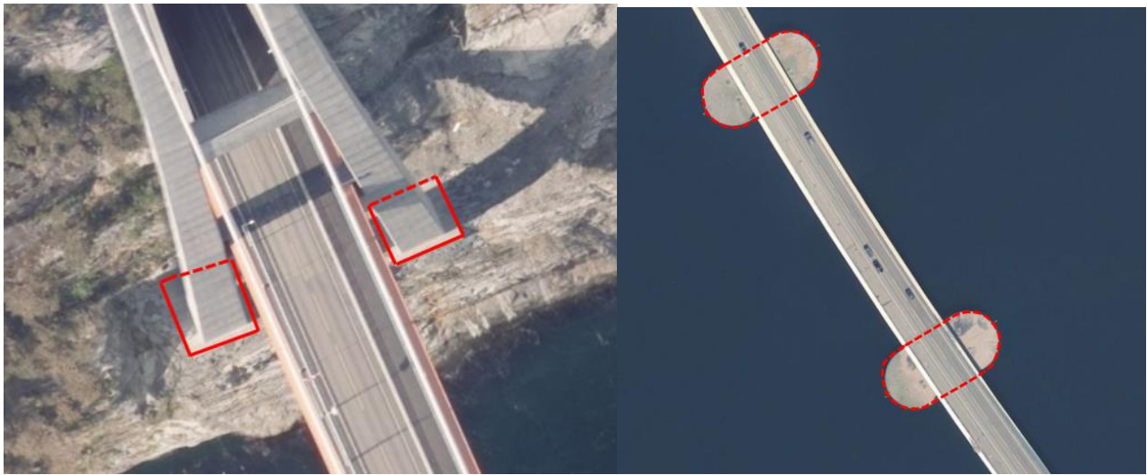
Figur 8: Eksempel på registrering av FundamentKant på fundamenter for bru (brukar, brupilarer). Registreres i den grad de er synlige på bildene. Dersom deler av kanten har dårlig innsyn angis dette ved bruk av kvalitetskoding.
