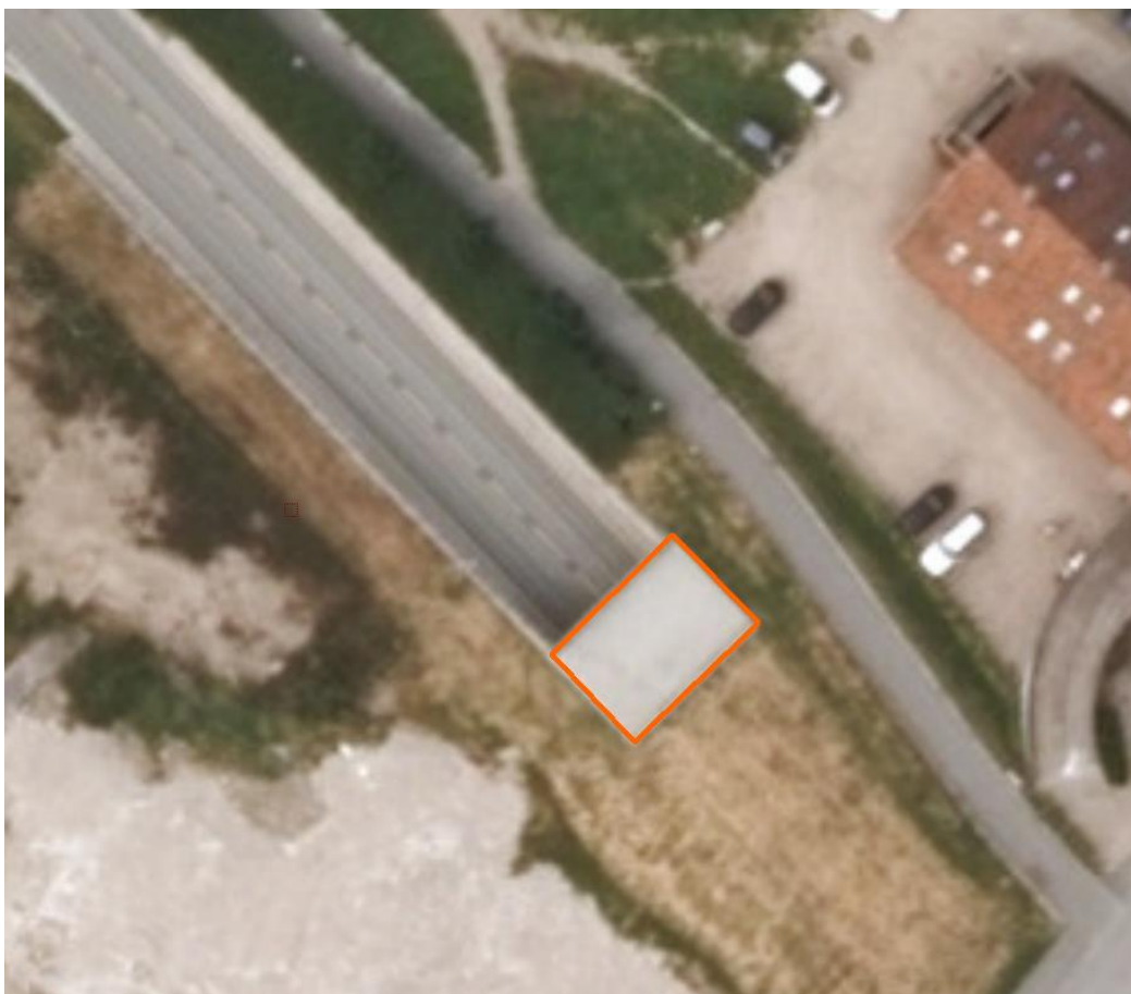
Figur 6: Eksempler på registrering av tunnelportal
