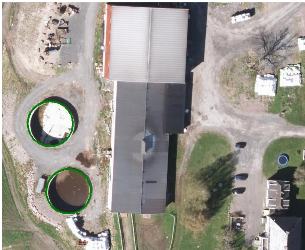
Figur 14: Eksempel på registrering av åpen gjødselkum som MurFrittstående.
