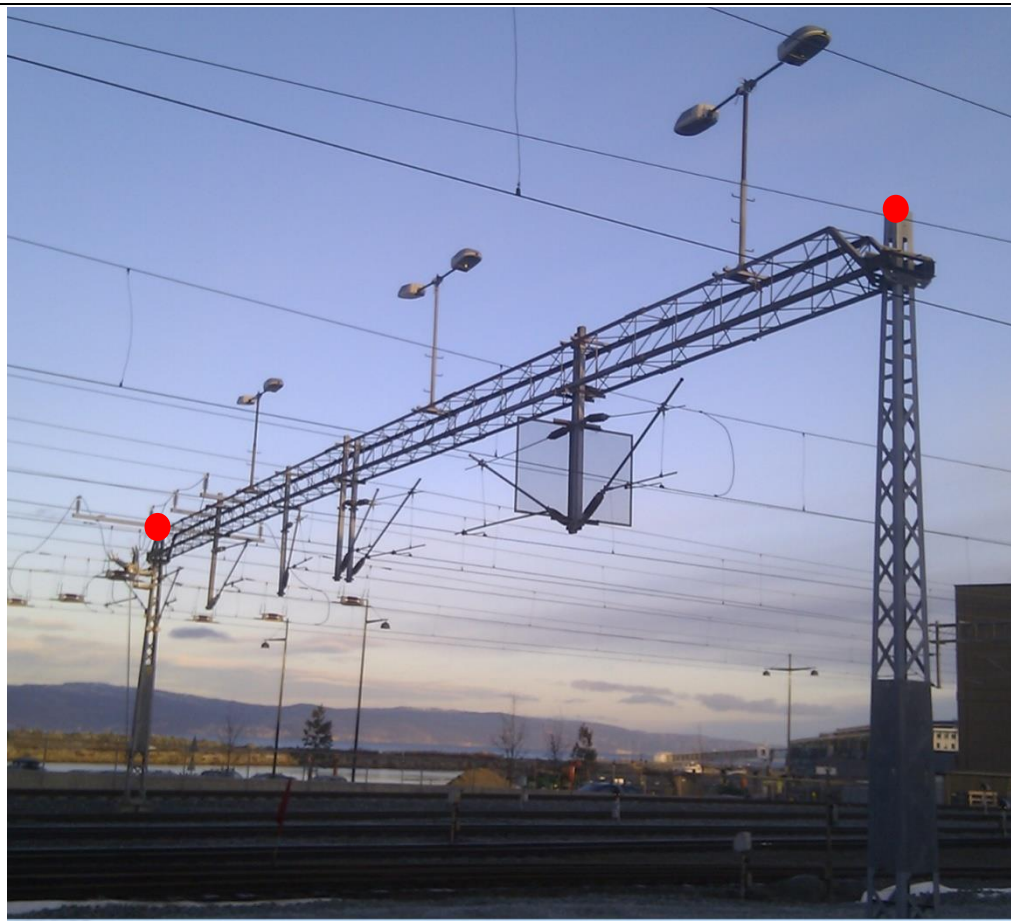
Figur 22: Eksempel på registrering av kontaktledningsmast med åk
