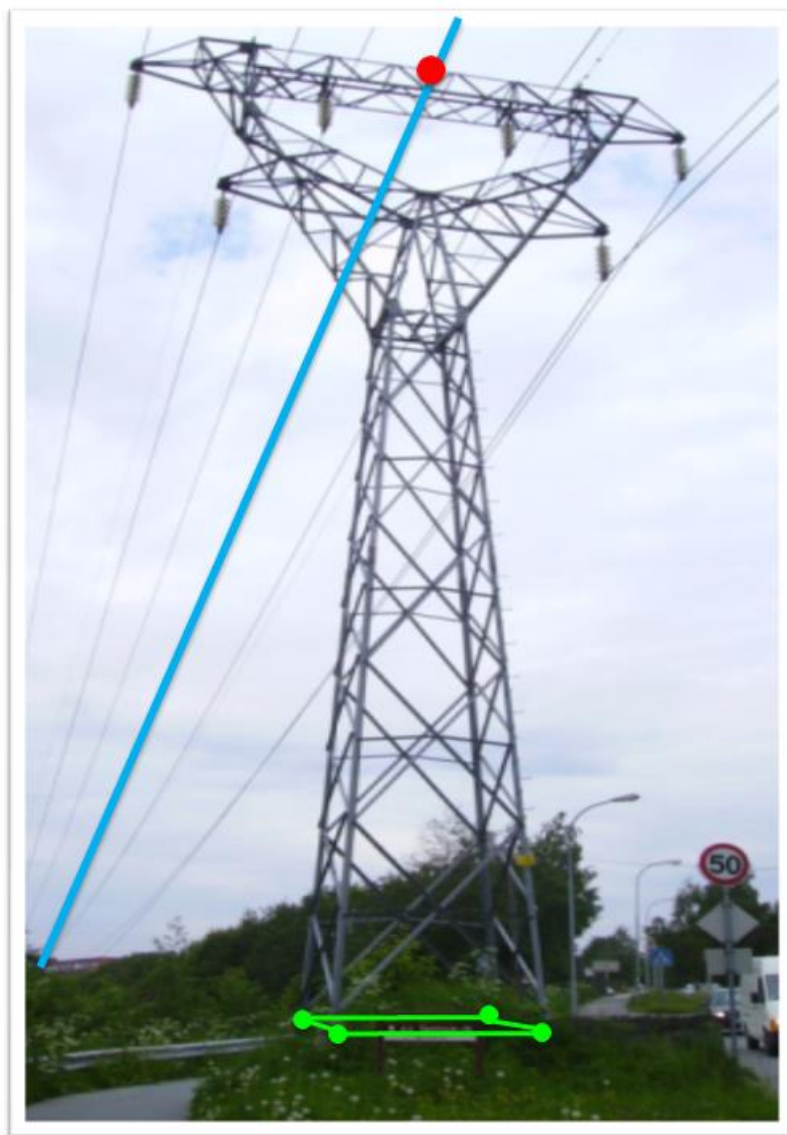
Figur 2: Eksempel på hvordan en fagverksmast med flere ledninger forenkles i FKB. I dette tilfellet registreres senter topp mast, omriss av fundament og senter ledningstrase. Ved at man registrerer høyde på mast og trase, kan man lage en forenklet 3D-modell av masten.
