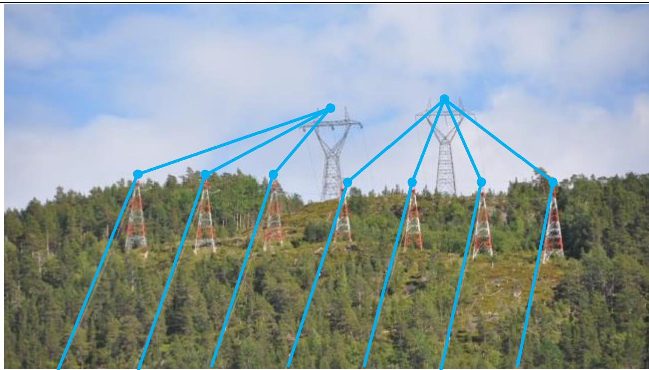
Figur 30: Eksempel på registrering av trase med fjordevføring.
