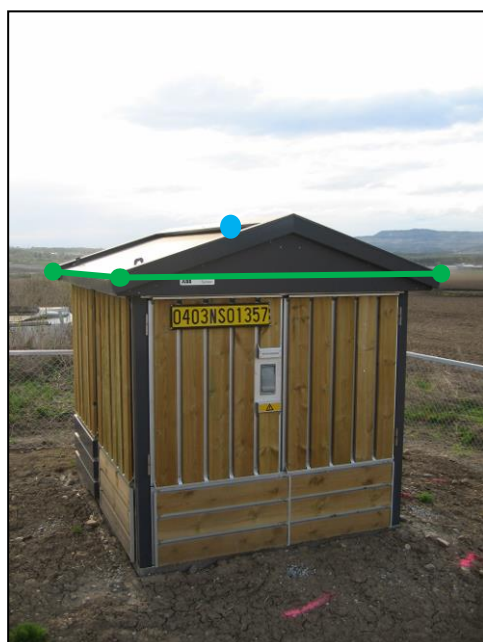
Figur 18: Eksempel på registrering av nettverkstasjon (EL_Nettstasjon) som omriss (grønn strek). Figuren viser også symbol for EL_Nettstasjon (minikiosk) (blå prikk), Dette punktet skal som minimum alltid være registrert.
