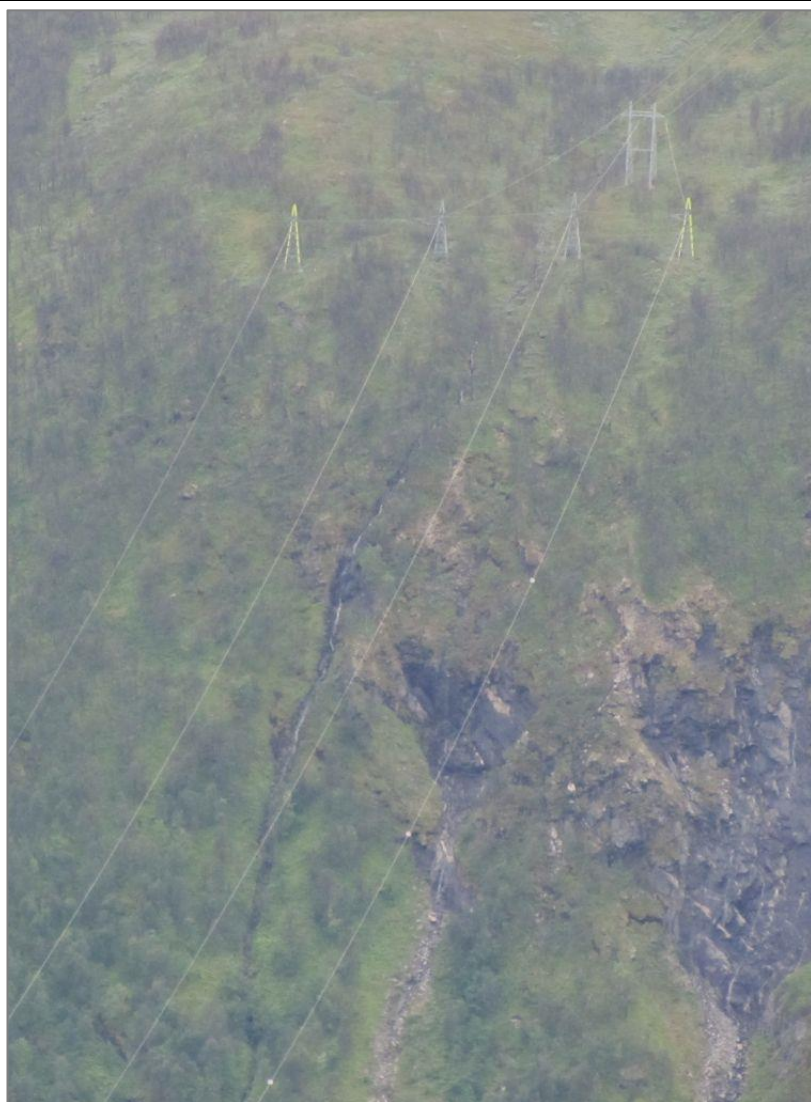
Figur 16: Eksempler på lange fjordspenn med flymarkører/blåser
