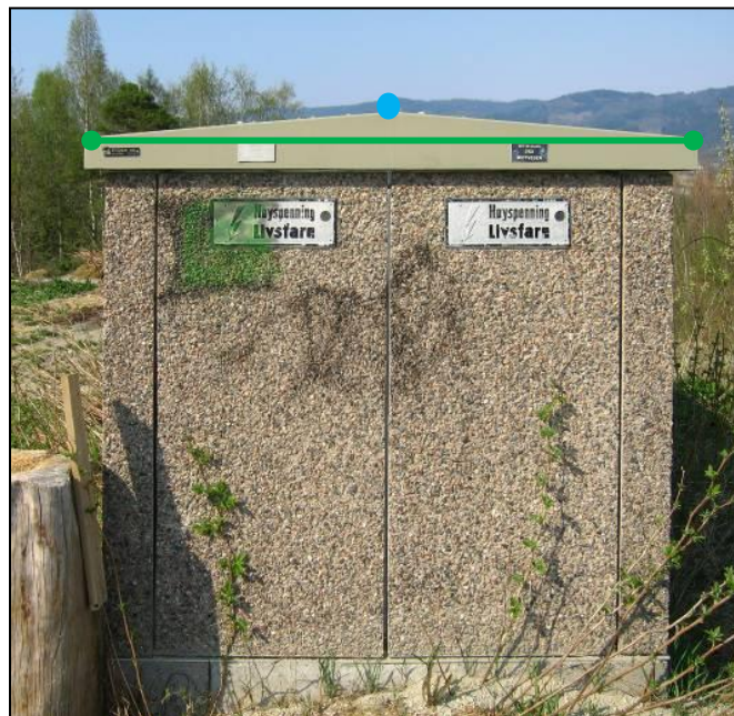
Figur 11: Eksempel på registrering av EL_Nettstasjon (Minikiosk) som representasjonspunkt (blå prikk). Figuren viser også Nettverkstasjonsomriss (EL_Nettstasjon) (grønn strek) som også skal registreres.
