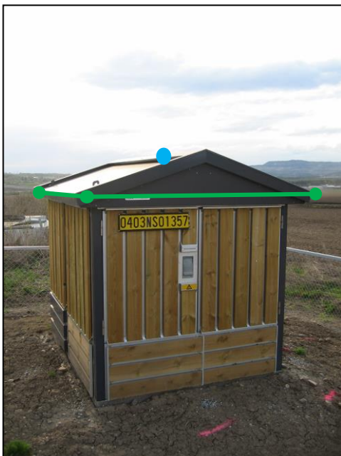
Figur 11: Eksempel på registrering av EL_Nettstasjon (Minikiosk) som representasjonspunkt (blå prikk). Figuren viser også Nettverkstasjonsomriss (EL_Nettstasjon) (grønn strek) som også skal registreres.
