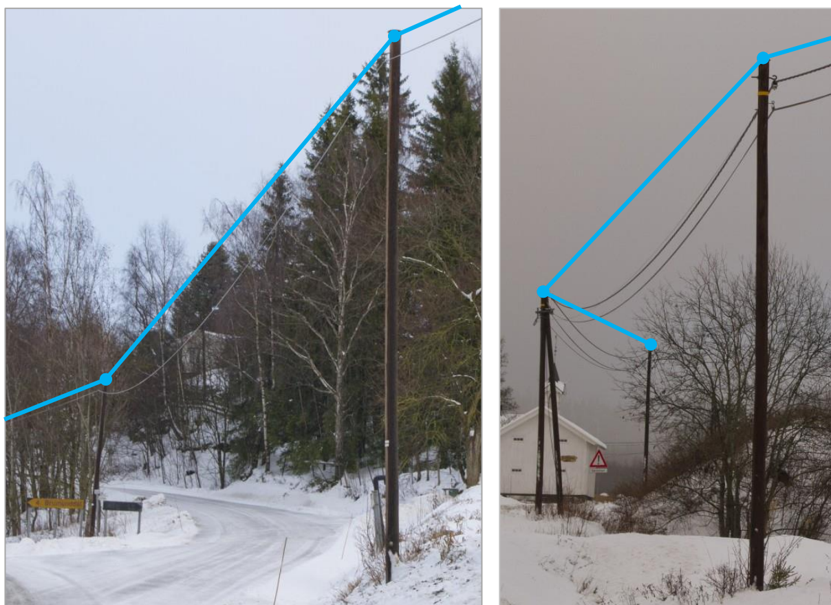
Figur 33: Eksempel på registrering av telelinje trase. I eksempelet til høyre benytter ekomtraseen de samme stolpene som en lavspennet trase (fellesføring).
