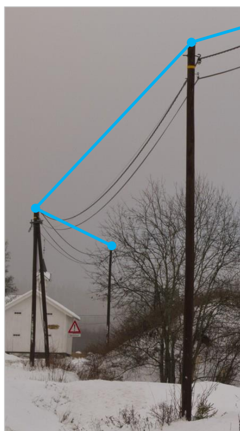
Figur 33: Eksempel på registrering av telelinje trase. I eksempelet til høyre benytter ekomtraseen de samme stolpene som en lavspennet trase (fellesføring).
