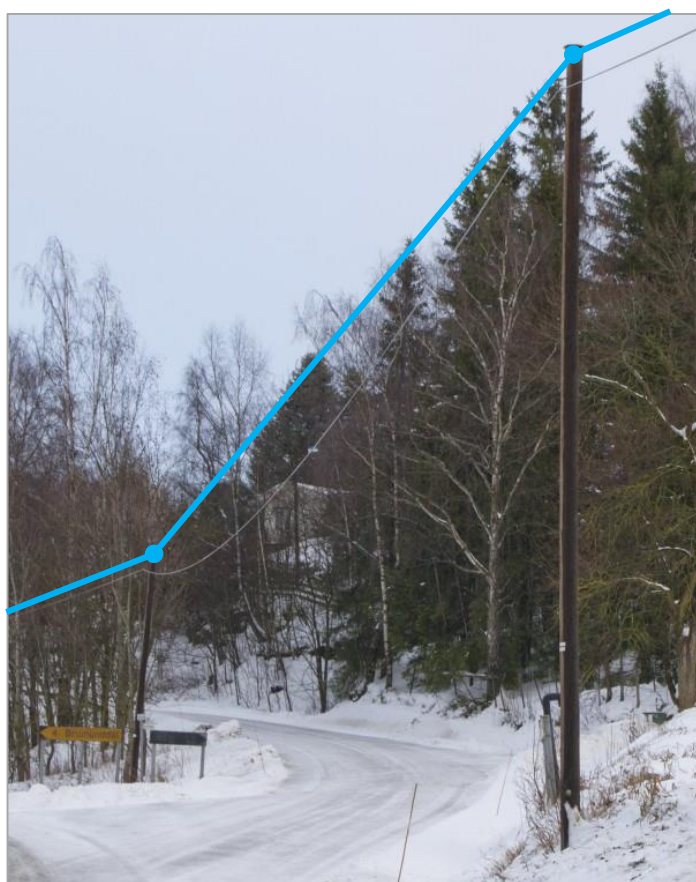
Figur 33: Eksempel på registrering av telelinje trase. I eksempelet til høyre benytter ekomtraseen de samme stolpene som en lavspennet trase (fellesføring).
