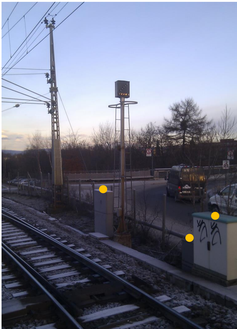
Figur 8: Eksempel på registrering av skap (gul prikk)
