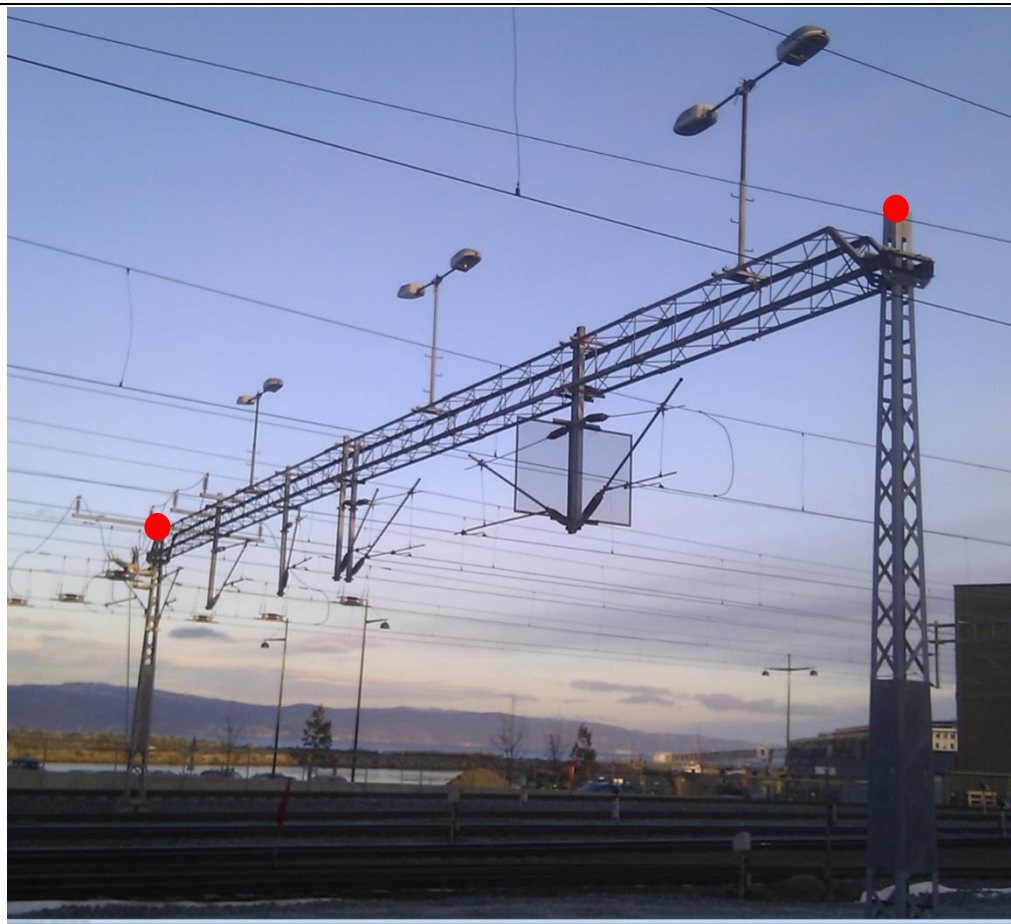
Figur 22: Eksempel på registrering av kontaktledningsmast med åk
