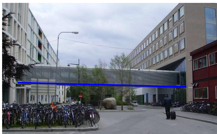
Figur 27: Øverst er et eksempel på registrering av bygningsbru (blå linje). I midten er et eksempel på bygningsbru inntil bygning og nederst er bygningsbru (overbygget/innglasset) mellom bygninger (overbygget skal registreres som takoverbygg).
