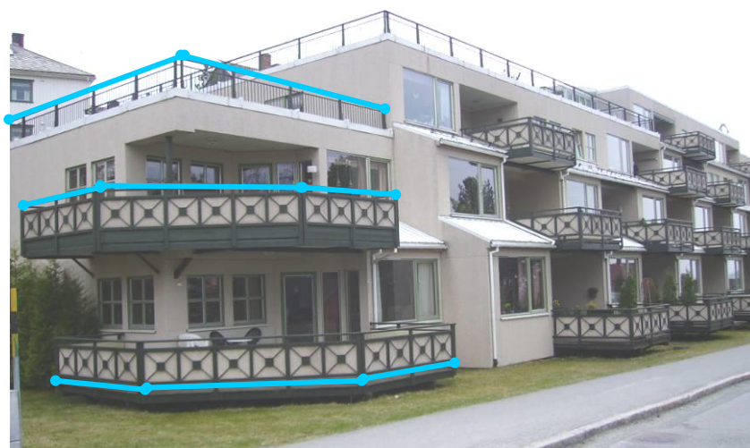
Figur 30: Figurer som viser registrering av veranda. I bildet nederst er det kun påført registrerte verandalinjer på deler av bygget.
