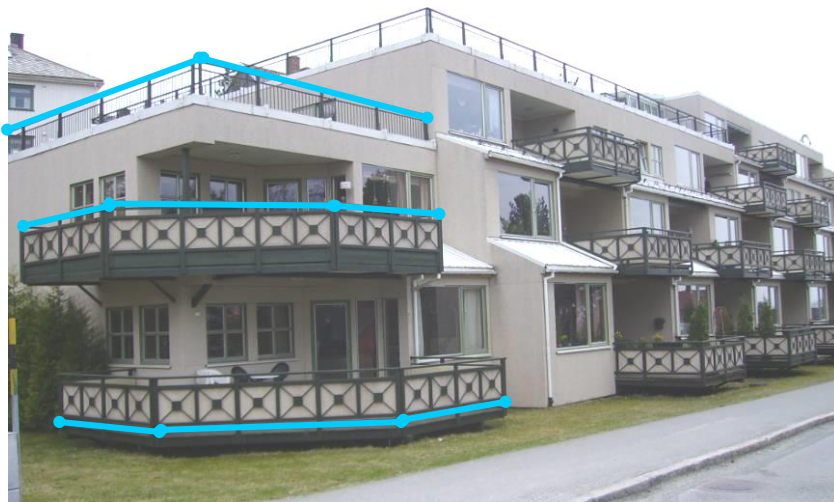
Figur 29: Figurer som viser registrering av veranda. I bildet nederst er det kun påført registrerte verandalinjer på deler av bygget.
