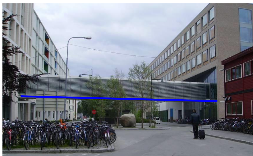
Figur 26: Øverst er et eksempel på registrering av bygningsbru (blå linje). I midten er et eksempel på bygningsbru inntil bygning og nederst er bygningsbru (overbygget/innglasset) mellom bygninger (overbygget skal registreres som takoverbygg).
